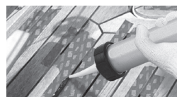
REEMPLACE EL SELLADO EN LAS ZONAS DONDE SEA NECESARIO CON TEAK JAMMER
